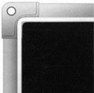
Прокладка установленная вплотную к нижней кромке фланца, закрывает открытую кромку воздуховода
